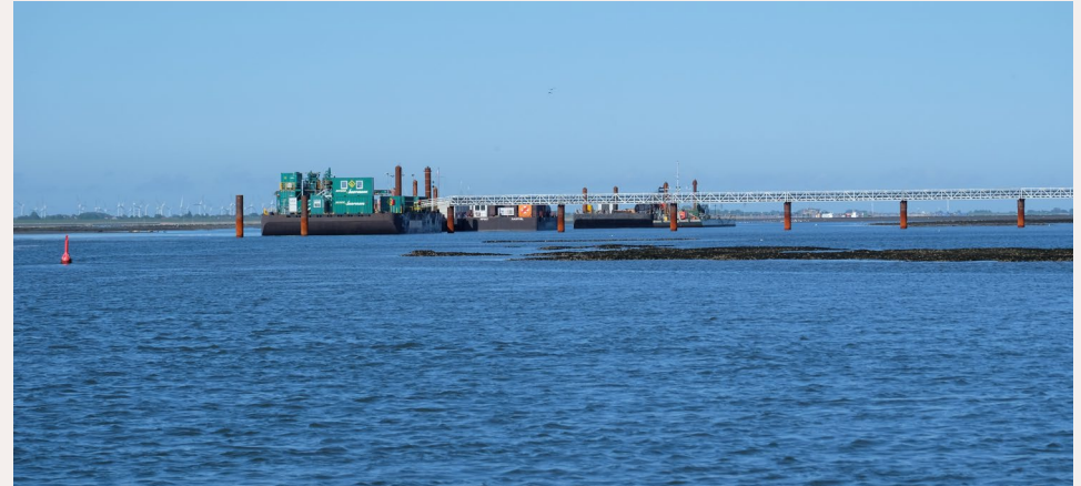
Seitliche Ansicht auf den Steg und Arbeitsbereich(Bohreintrittspunkt) / Quelle: TenneT
