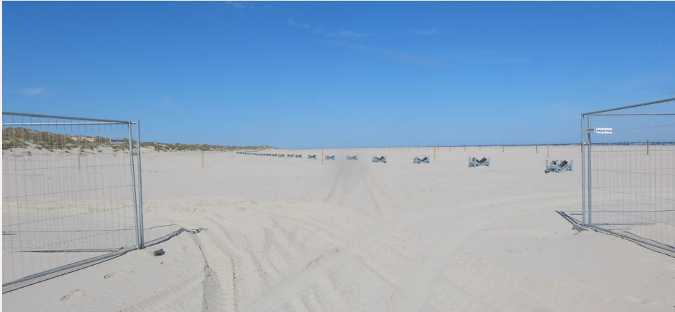
Rollenböcke am Nordstrand / Quelle: TenneT
