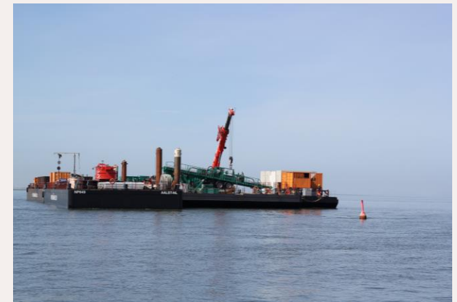
Bohrgerät auf der späteren Arbeitsplattform / Quelle: TenneT
