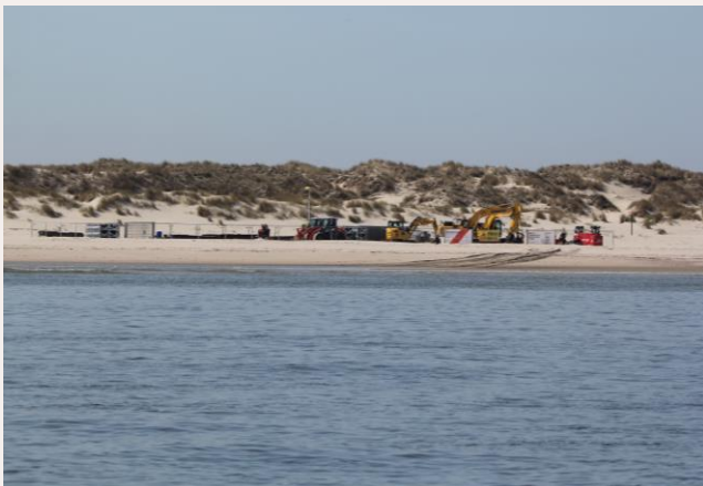
Baugeräte am Nordstrand Status Quo / Quelle: TenneT
