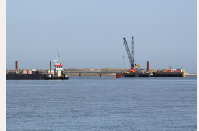
Errichtung des Wattstegs mittels Arbeitspontons / Quelle: TenneT
